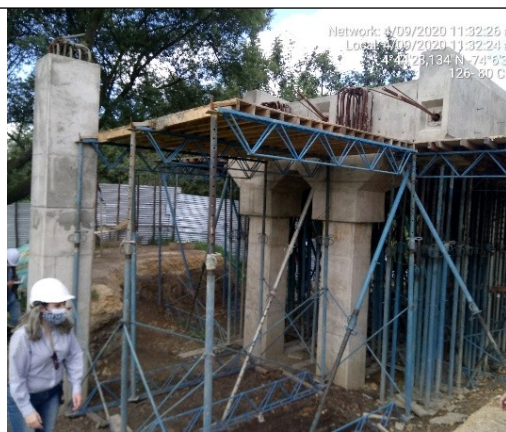
Fotografía No. 6. Refuerzo provisional de cerchas, párales de apoyo y andamios en el puente Cortijo
